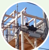
御幣は屋根裏へ納められました。
