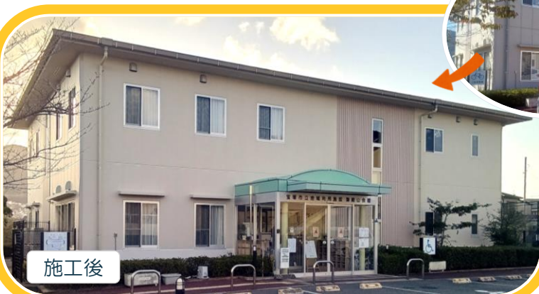
外壁改修工事
